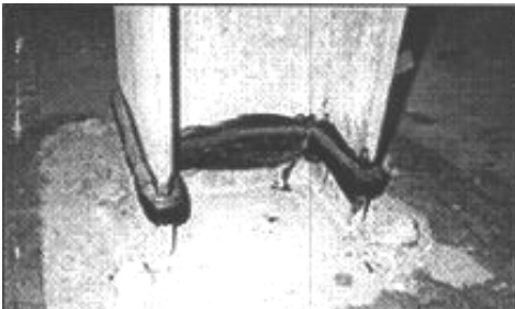
In jurul elementelor de structura din beton
